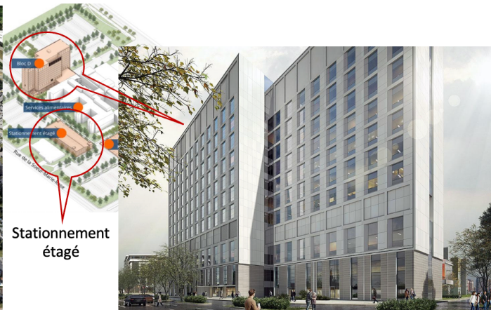
Agrandissement présentement en construction
