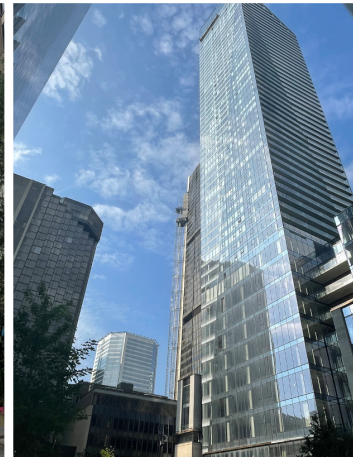
Tour Victoria sur le parc
