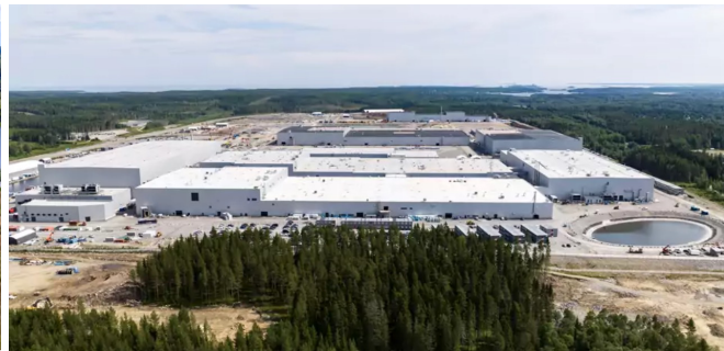
L'usine Northvolt de Suède, semblable à celle qui sera construite à McMasterville
